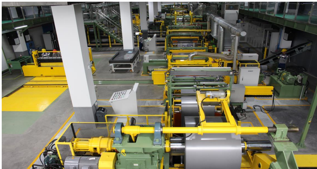
案例一：二期工业工程竣工投产场景概貌
